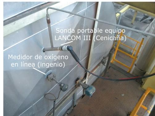
Analizador de gases portátil (Lancom III) instalado cerca del medidor continuo de nivel de oxígeno de la caldera de un ingenio suco-energético
