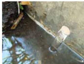
Lámina perforada para aforo
