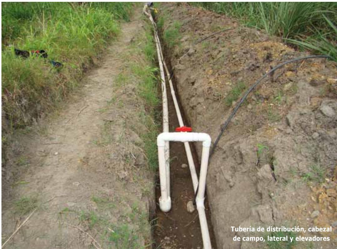
Tubería de distribución, cabezal de campo, lateral y elevadores
