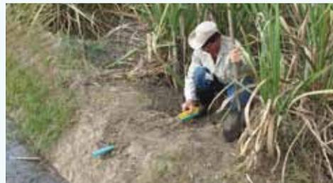
Los tubos cortos se instalan en posición horizontal, sumergidos a 10 cm del nivel superior del talud.
