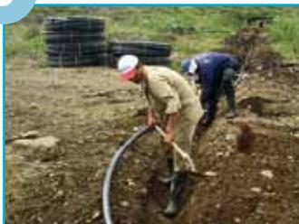
Tubería de conducción
