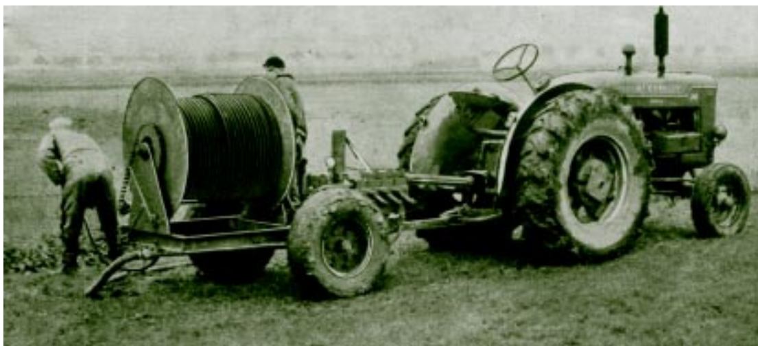
Equipo para limpieza de drenes por inyección de agua a presión.
