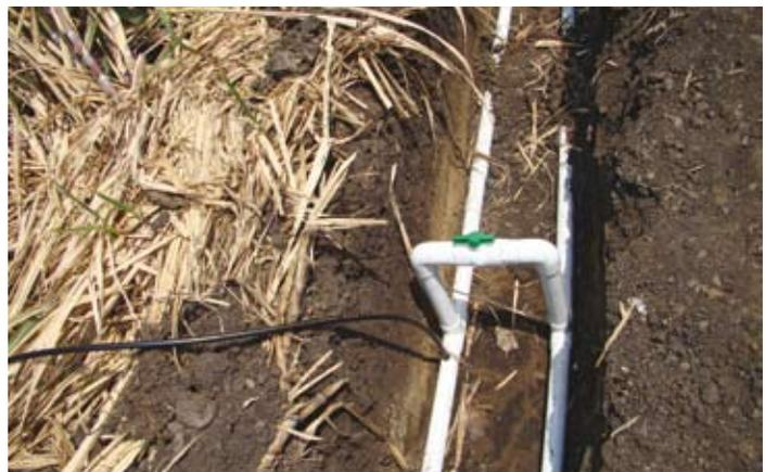
Figura 4. Distribución, llave de paso y elevador en el sistema de riego con caudal reducido. Hacienda El Waco, Ingenio Mayagüez.
