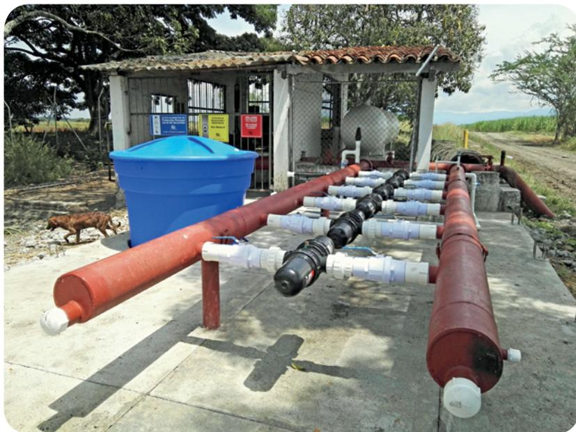
► FIGURA 2.4. Batería de filtros de anillos en un sistema de riego por goteo.
