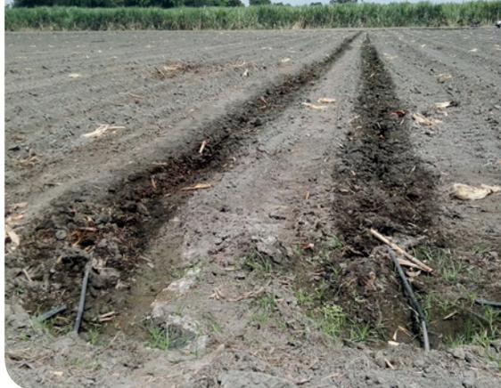
Laterales enterrados en un sistema de riego por goteo subterráneo (SDI).
