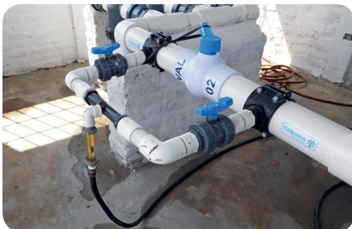
► **FIGURA 2.10.** Diseño de un sistema venturi modificado para la aplicación de fertilizantes en riego por goteo: esquema y estación de campo.
