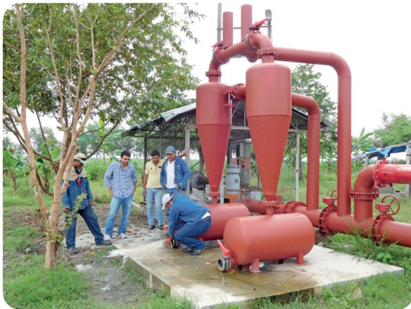
► FIGURA 2.2. Filtro hidrociclón: esquema y estación de campo.
