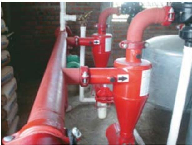
**Estación de filtrado para garantizar la calidad del agua utilizada en el riego por goteo.**
