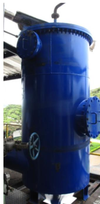
**El condensador barométrico con un nuevo diseño, a partir de modificaciones realizadas por Cenicaña, se implementó en un ingenio y logró reducir el consumo de agua en fábrica, en promedio, en 50%.**
