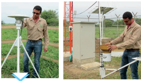
Durante 2017 continuará la instalación de estaciones de la Red RTK y la configuración de los equipos con señales de 450 y 900 MHz.
