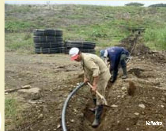
**1 Captación.** La toma de agua se realiza desde una fuente ubicada en un reservorio o corriente natural. En el punto de captación es indispensable colocar un filtro para evitar la entrada de materiales gruesos que puedan taponar la tubería.
