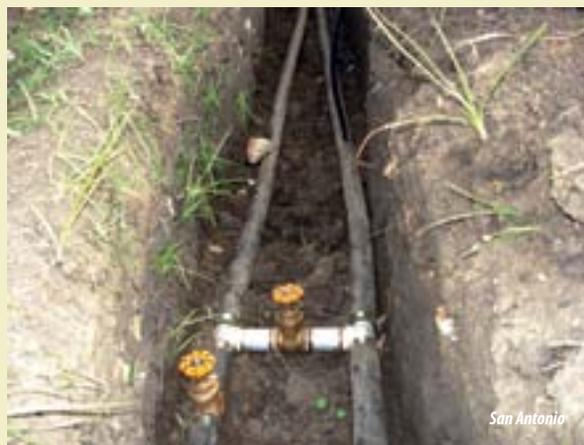
**3 Distribución.** Se conecta a la tubería de conducción y distribuye el agua a los tabloncillos y suertes (lotes).
