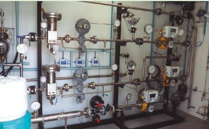
Inyección a la red. Según la presión de la red. (10 hasta 70bar).
