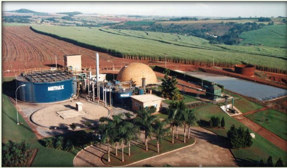
Planta de biodigestão anaeróbica de vinhaça da Usina São João, São João da Boa Vista, SP (1986) - desativada .
