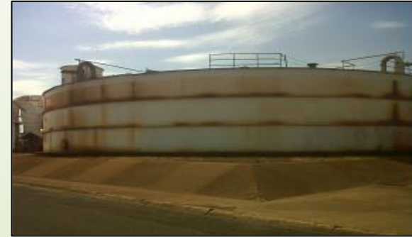
Biodigestor (UASB – termofílica) instalado em 1995 na Usina São Martinho, SP ( operando )
